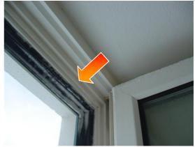
Es kommt bei den gegenüber früher höheren Luftdichtigkeiten heutiger Wohnungen durch die verbleibenden kleineren Undichtheiten, die zum Teil an unseren Fenstern noch vorhanden sind, bei ungünstigen Bedingungen durch kontinuierliches Durchströmen der feucht-warmen Raumluft nach außen zu einem teilweise schädlichen Kondensatausfall im Falzbereich.
